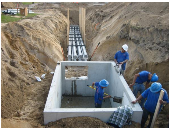
شکل ۱- کانال کشی به روش سنتی در شبکه مخابراتی [۱]
